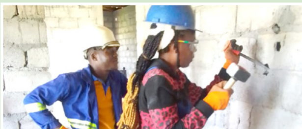
Electriciens au chantier
