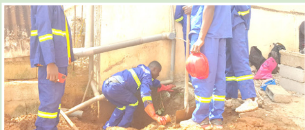
Plombiers en intervention
